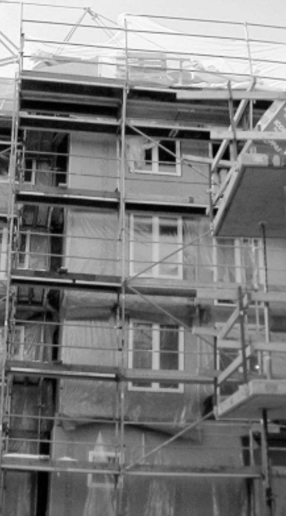
Utfackningsparti av trä, mineralull och gips.
